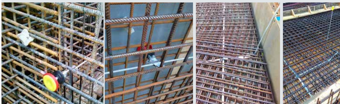
Praxisbilder 6-9: Erdungspunkte und Anschlussfahnen
