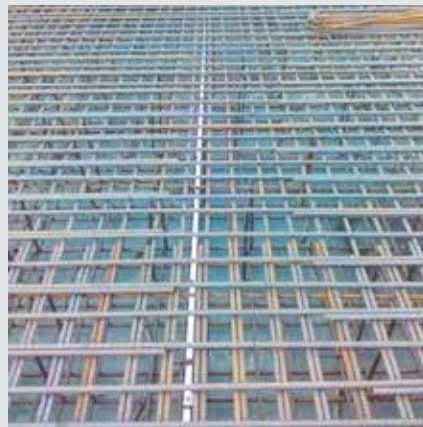
Praxisbilder 1-3: Fundamenterder bzw. kombinierte Potentialausgleichsanlage
