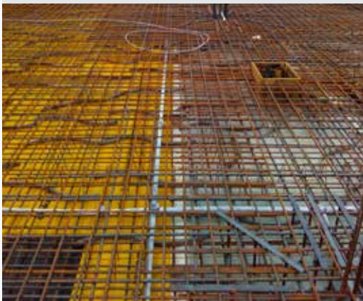
Praxisbilder 1-3: Fundamenterder bzw. kombinierte Potentialausgleichsanlage
