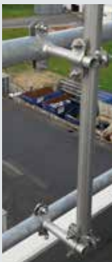
Sonderbefestigung in Edelstahl für Fangmaste
