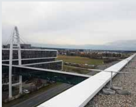
Sonderbefestigung in Edelstahl für Fangmaste
