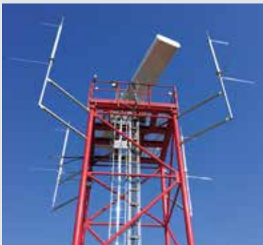
Sonderbefestigung in Edelstahl für Fangmaste
