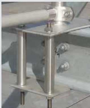
Sonderbefestigung in Edelstahl für Fangmaste
